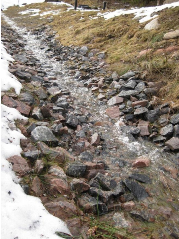
Figur 15. Exempelbild på erosionsskyddat dike. 7
