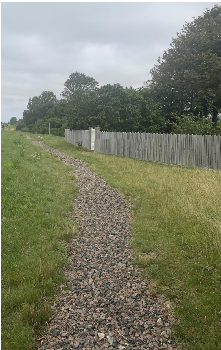
Figur 17. Exempelbild på makadamdike. Foto taget av Bjerking AB.
